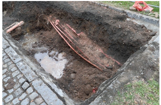
Archeologický výzkum a dozor při výkopových pracích před instalací podzemních kontejnerů
