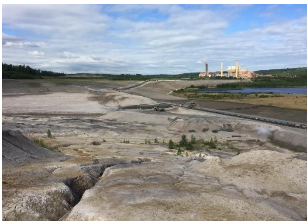
Celkový pohled na prostor bývalého lomu Silvestr od jihovýchodu, 26. 5. 2022
