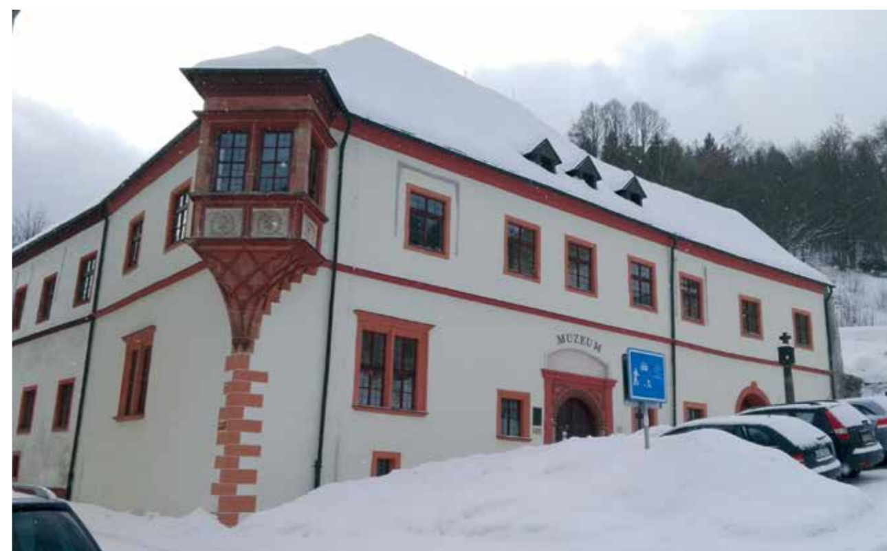
Nahoře: Objekt Muzea Karlovy Vary na Nové louce, se stálou expozicí, výstavními a přednáškovým sálem, rekonstrukce objektu dokončena v roce 2017
